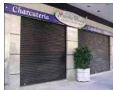
Imagen 39. Cierre metálico enrollable ciego
