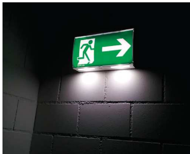
Imagen 11. Salida de emergencia
