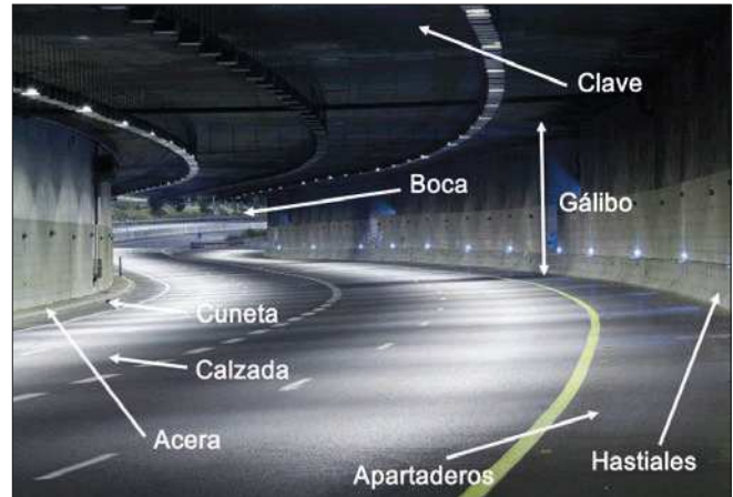
Imagen 1. Partes de un túnel
