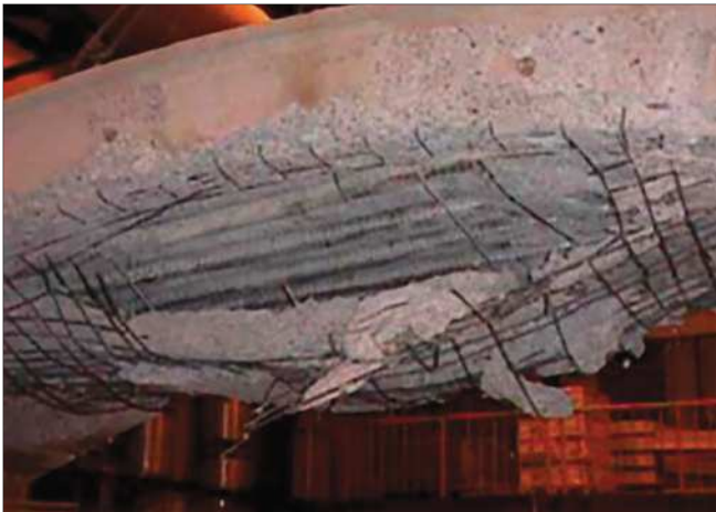
Imagen 20. Spalling
