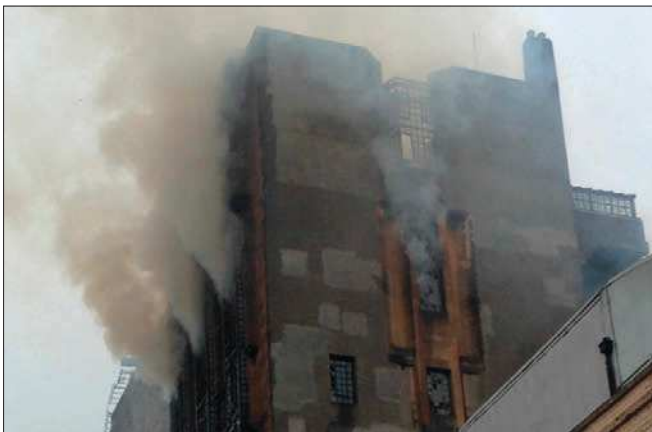
Imagen 168: El acceso a viviendas en altura dificulta las operaciones de extinción
