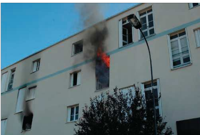
Imagen 23. Incendio en estado ILC
