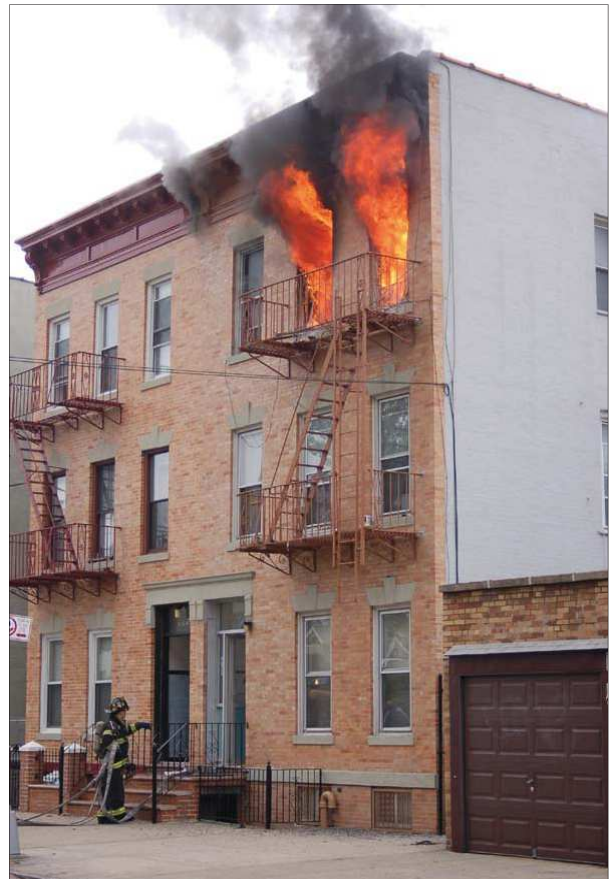
Imagen 47. Incendio en el que se puede identificar claramente el flujo de gases. La puerta del edificio funciona como entrada de aire y los ventanales abiertos como salida
