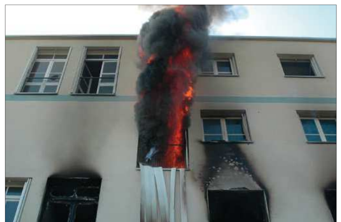
Imagen 24. Incendio en estado ILV
