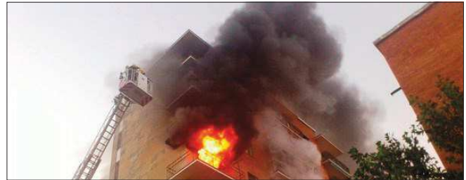
Imagen 175: Incendio con salida de humo en régimen turbulento
