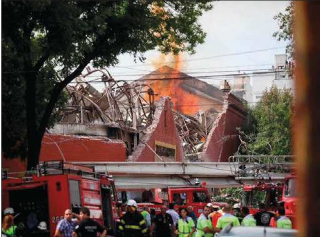
Imagen 164: El colapso de una estructura durante las tareas de extinción de una nave industrial en Barracas (Buenos Aires, Argentina) se llevó la vida de 10 bomberos
