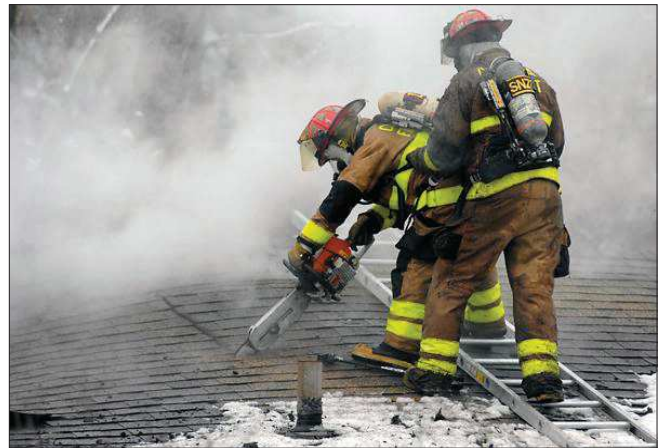
Imagen 108. Ventilación natural en cubierta
