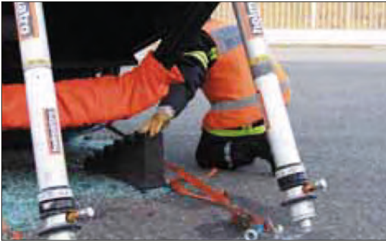
Imagen 276. Bloques de estabilización
