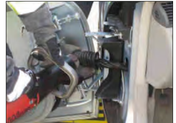
Imagen 194. Corte de cables
