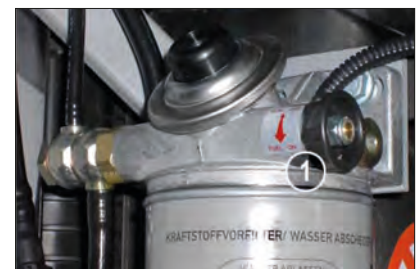
Imagen 116. Cortar el suministro de combustible
