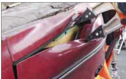
Imagen 229. Separación de la puerta y corte en el perfil
