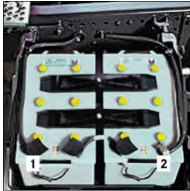
Imagen 122. Caja de baterías en el lado del conductor (1) Polo Positivo, (2) Polo Negativo
