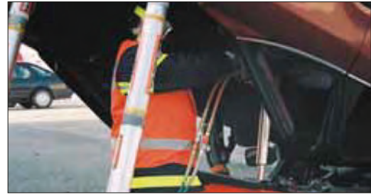
Imagen 280. Retirada de techo con cilindro separador
