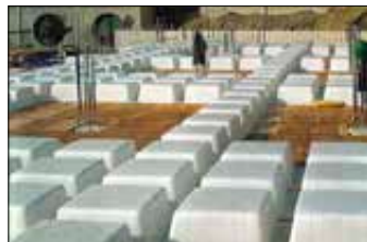
Imagen 345. Losa aligerada
