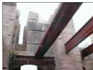
Imagen 144. Apertura de huecos en forjados
