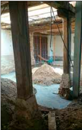
Imagen 277. Pie derecho con basa y zapata
