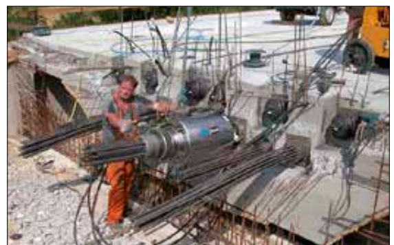
Imagen 74. Hormigón pretensado (armadura postesa)
