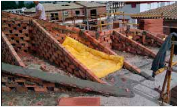
Imagen 378. Colocación de aislamiento térmico
