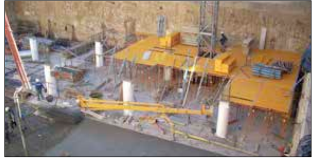
Imagen 258. Construcción de estructura portante del edificio
