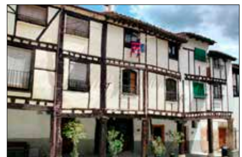
Estructura muros entramados
