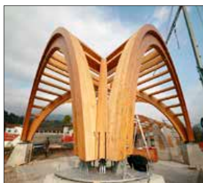
Estructura a base de madera laminada
