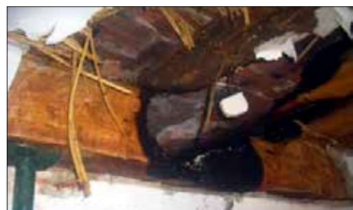
Imagen 456. Comportamiento al fuego de la madera
