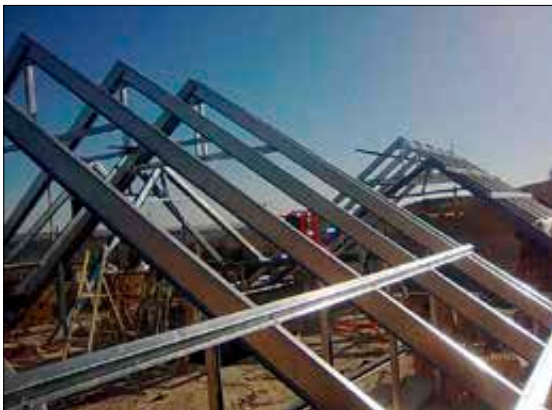
Imagen 366. Estructuras metálicas aligeradas
