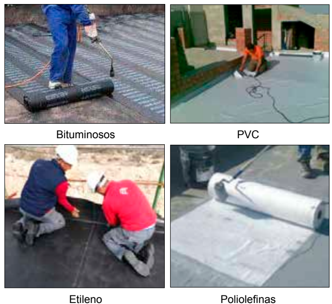
Imagen 400. Tipos de capas de impermeabilización
