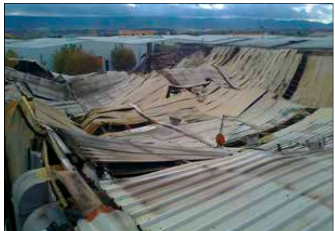
Imagen 447. Comportamiento del acero al fuego
