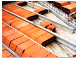
Imagen 319. Forjados pretensados
