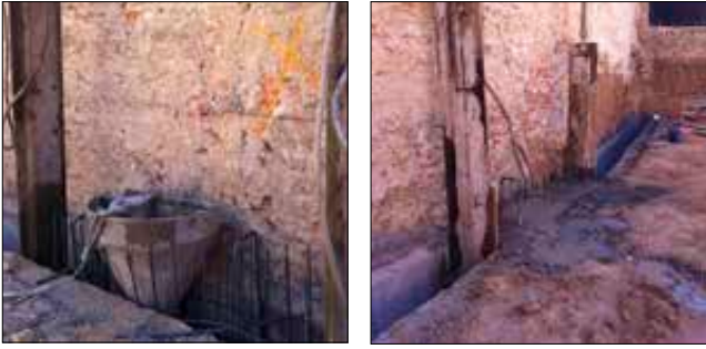
Imagen 253. Hormigonado por bataches
