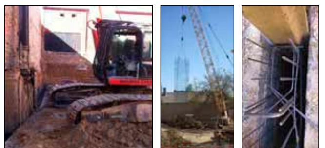
Imagen 251. Vaciado con cucharas bivalvas
