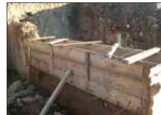
Encofrado y vertido
