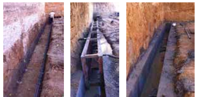
Imagen 250. Ejecución de murete guía
