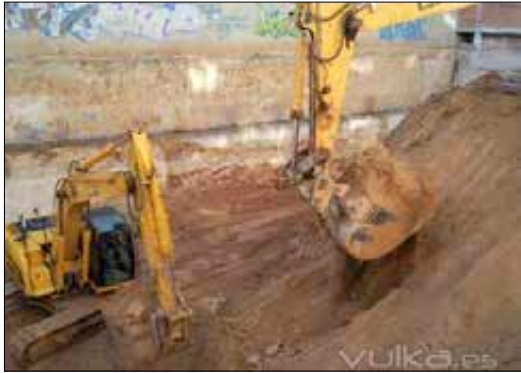
Imagen 254. Vaciado parcial tierras
