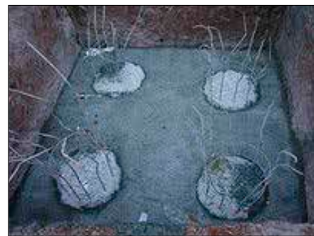
Imagen 237. Descabezado de los pilotes
