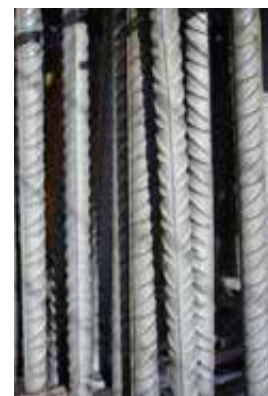
Imagen 129. Acero de armar
