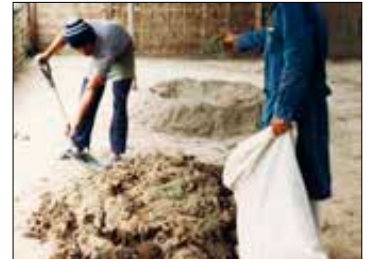
Mezcla arido, paja y agua sin formar barro
