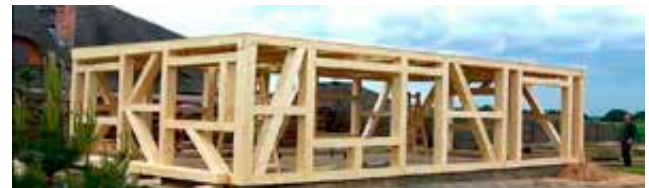
Imagen 273. Muro entramado
