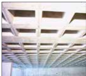
Imagen 372. Forjado bidireccional
