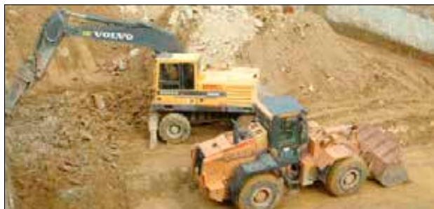
Imagen 256. Vaciado total de tierra
