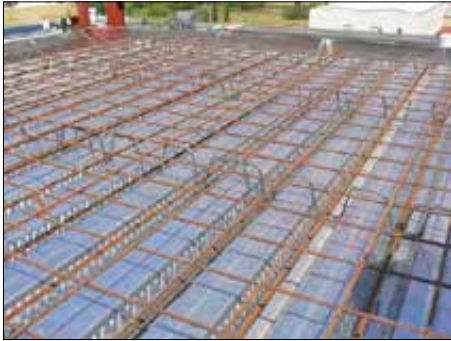
Imagen 341. Armaduras electrosoldadas
