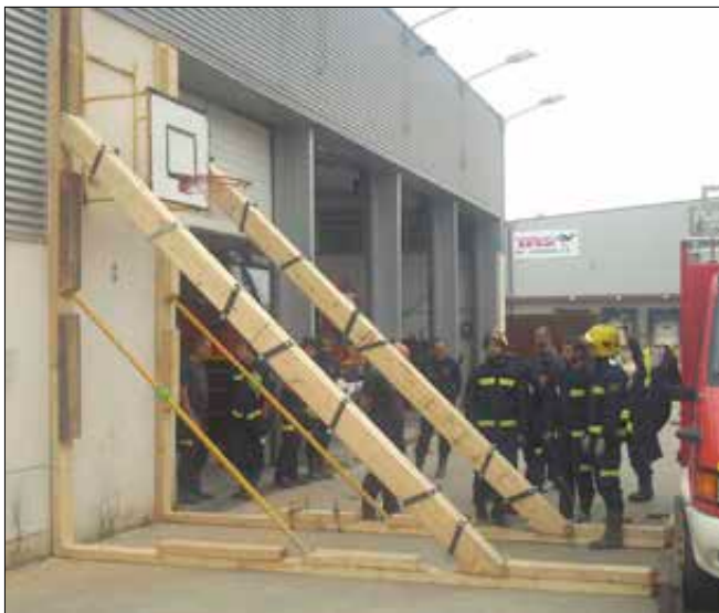
Imagen 602. Apeo en muro
