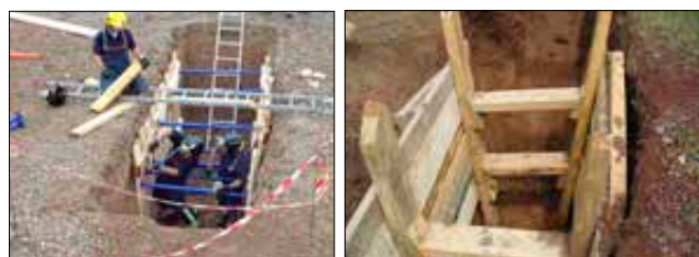
Imagen 550a. Entibaciones en zanjas: geometría.
