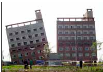
Imagen 631. Deslizamiento estratos
