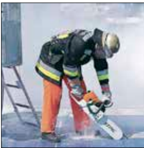
Demolición por corte
