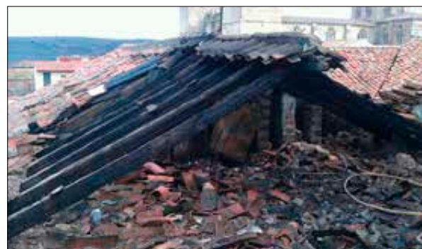
Imagen 674. Cubierta de par e hilera carbonizada
