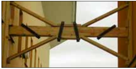
Imagen 550b. Entibaciones en zanjas: rigidez.
