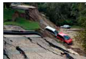
Imagen 675. Deslizamiento del terreno
