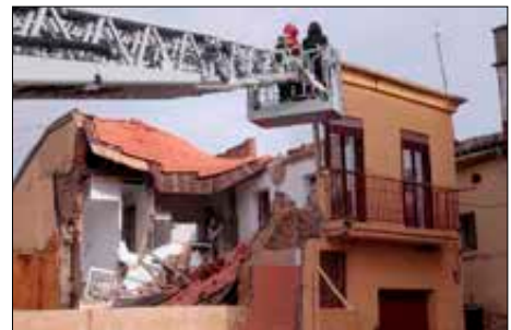
Imagen 633. Excavaciones en terrenos colindantes
