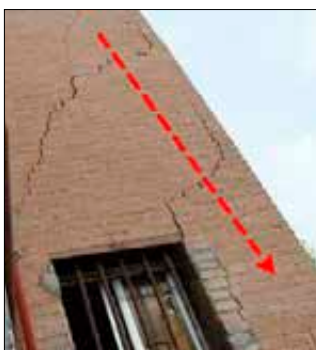
Imagen 604. Abombamientos y otras lesiones
