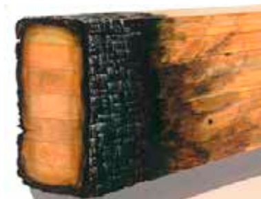
Imagen 672. Madera carbonizada superficialmente
