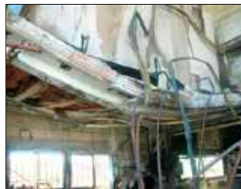
Imagen 658. Forjado HA sobre viga acero
