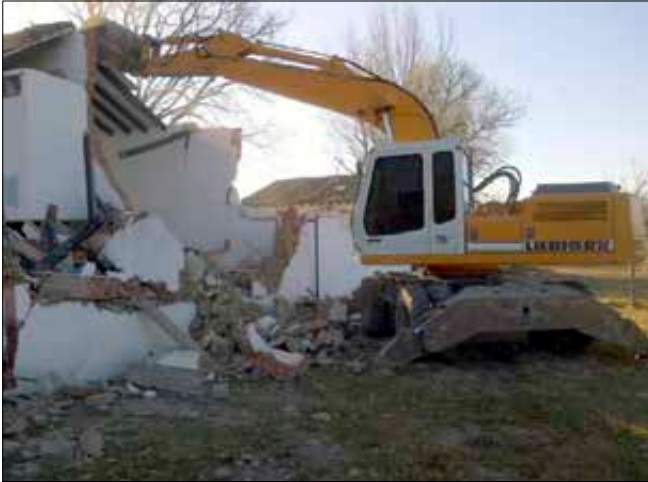
Demolición por empuje
