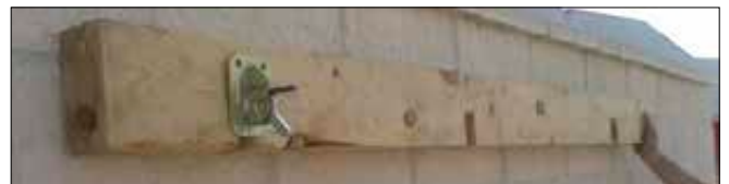
Imagen 567. Ejecución de Zapata mural (Idéntico a Vela)
