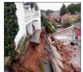
Imagen 654. Desplome muros
