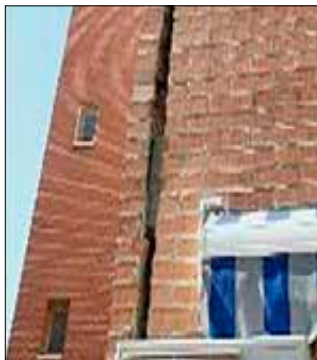
Imagen 639. Empuje forjado intermedio
