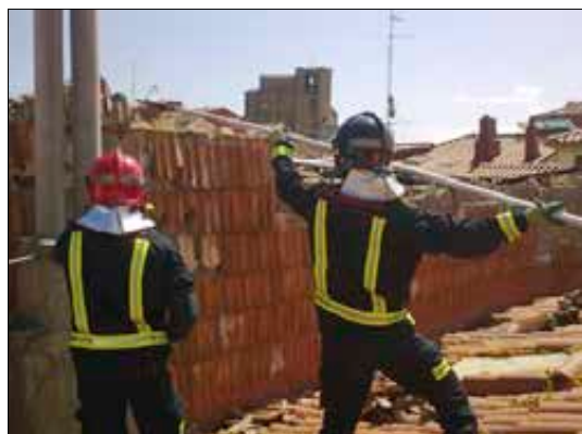
Imagen 522. Saneamientos y demoliciones
