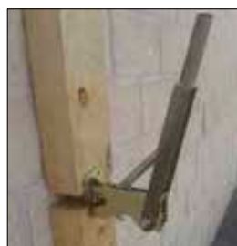
Imagen 566. Sistema de tensado de ranas
