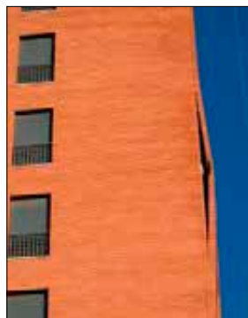
Imagen 639. Empuje forjado intermedio
