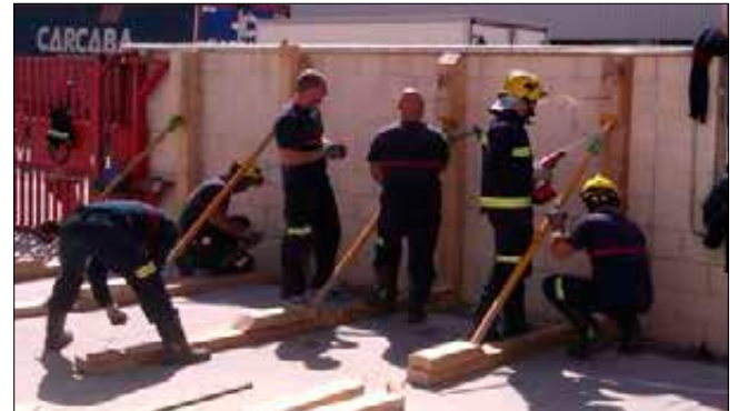
Imagen 568. Gran velocidad de ejecución
