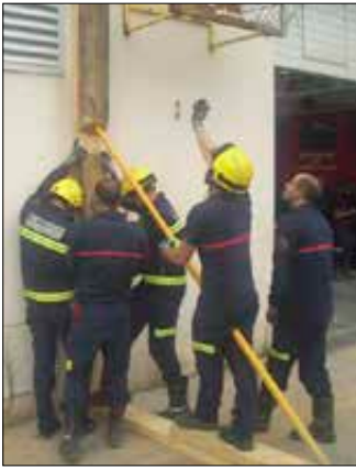
Imagen 600. Aplomado, acuífado y claveteado
