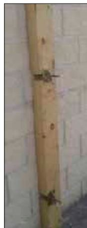
Imagen 564. Cajeadado de vela y fijación a muro mediante ranas
