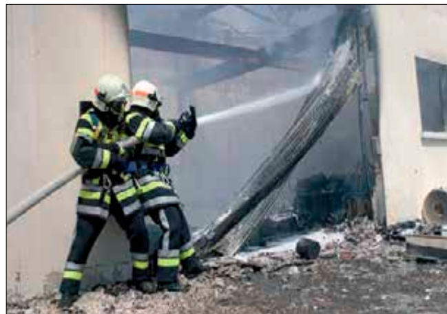
Imagen 667. Colapso interno de estructura prefabricada
