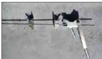
Imagen 562. Atado mediante ranas de encofrado
