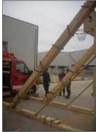
Imagen 601. Ejecución de piezas
