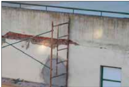
Imagen 638. Empuje cubierta
