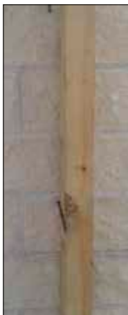
Imagen 563. Perforación muro, colocación pasadores y marcado de vela
