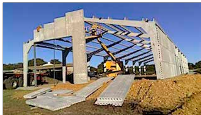
Imagen 665. Montaje nave industrial prefabricada
