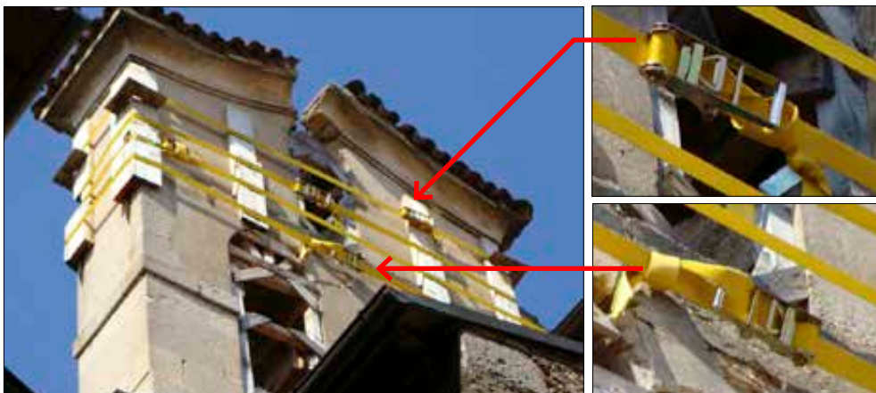
Imagen 583. Colocación cintas de carraca
