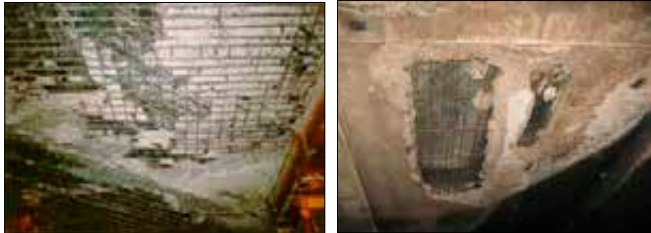
Imagen 669. Spalling
