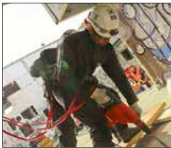
Demolición por perforación
