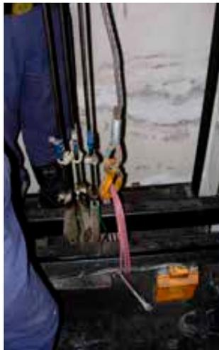
Imagen 48. Tráctel enganchado al chasis de la cabina
