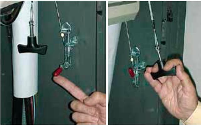
**Imagen 40.** Método mecánico de apertura. El dedo de la mano derecha está accionando un freno
