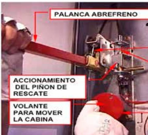
**Imagen 42.** Otros métodos mecánicos de apertura
