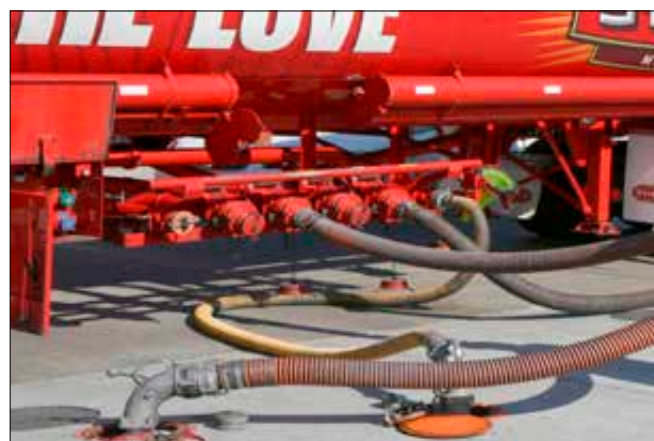
Imagen 141. Compartimento de descarga
