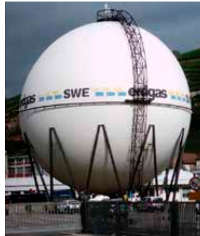
Imagen 172. Depósitos gas natural
