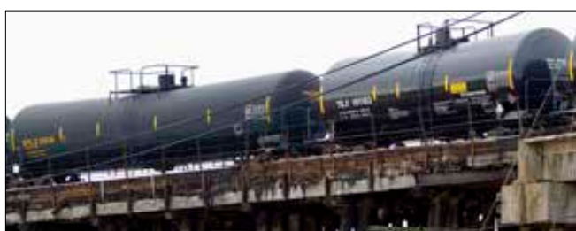
Imagen 124. Cisterna aislada al vacío
